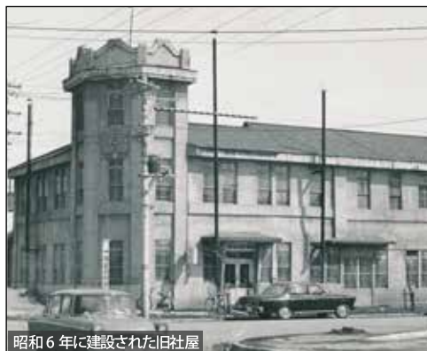
昭和6年に建設された旧社屋
