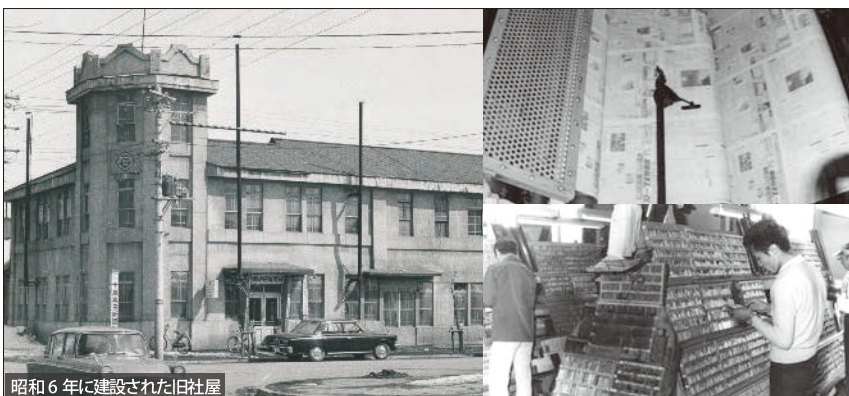
昭和6年に建設された旧社屋
